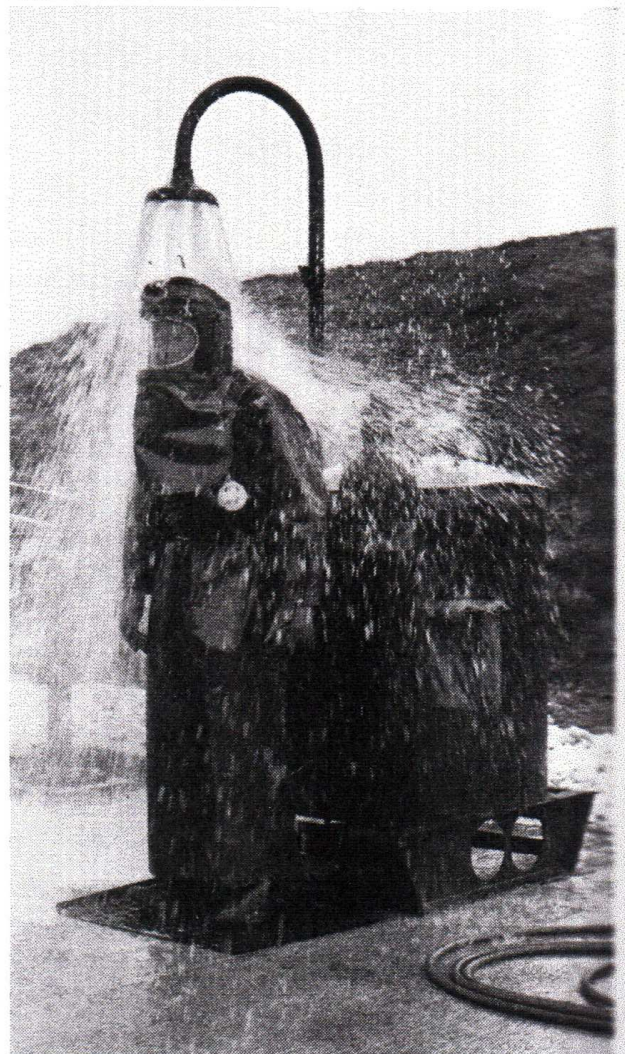
Efter påfyldningen afskylles eventuelle syrestærke under den kraftige bruser, inden beskyttelsesdragt og iltapparat tages af.
