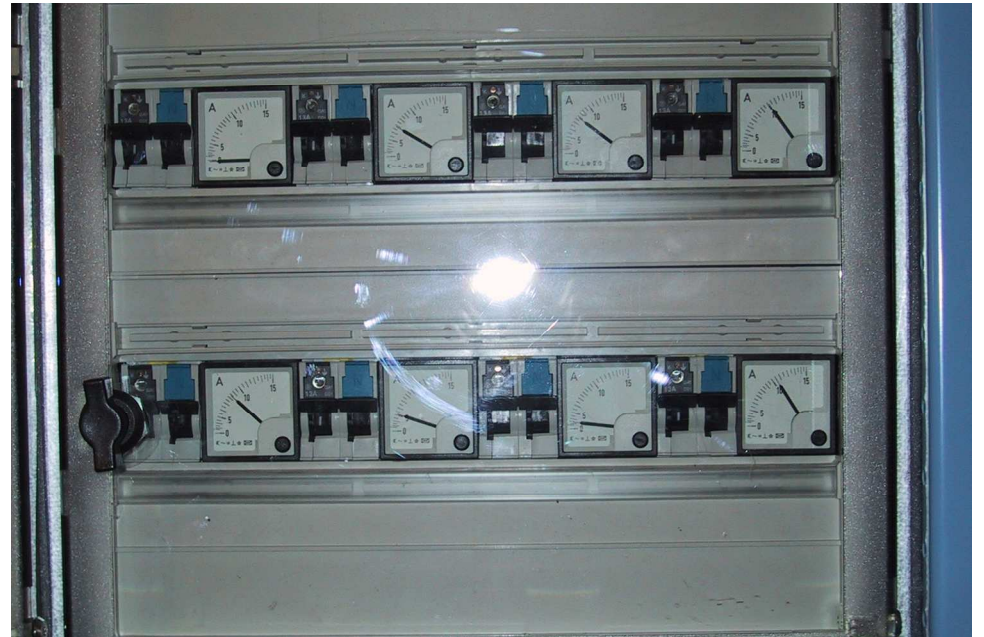
Nov.2001: Installation af nye eltavler
