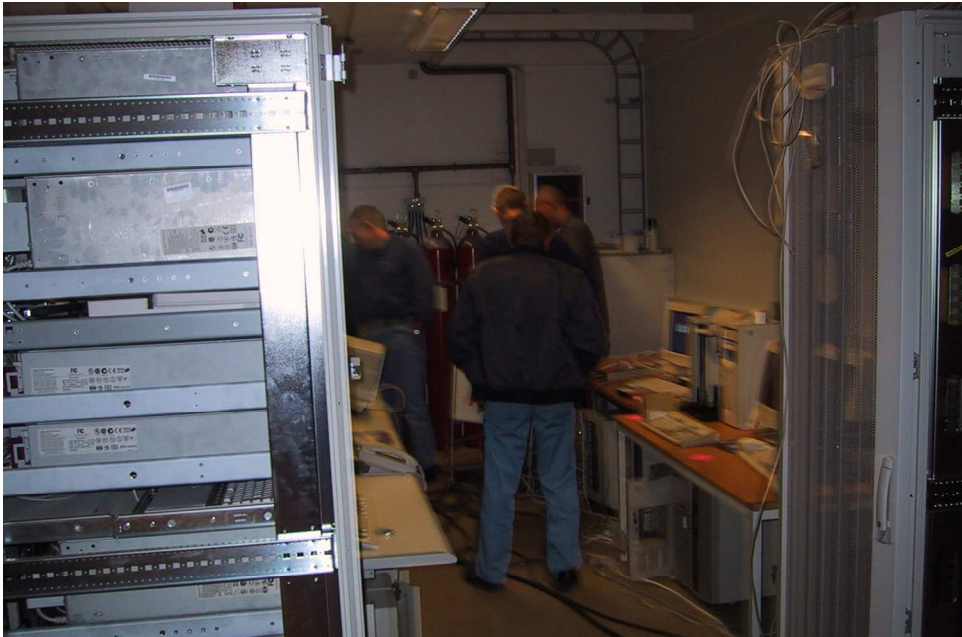
Nov.2001: Installation af nye eltavler
