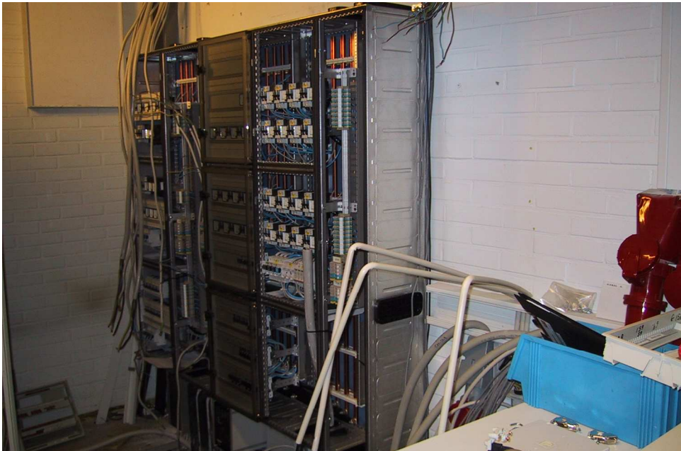
Nov.2001: Installation af nye eltavler
