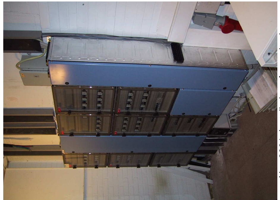
Nov.2001: Installation af nye eltavler
