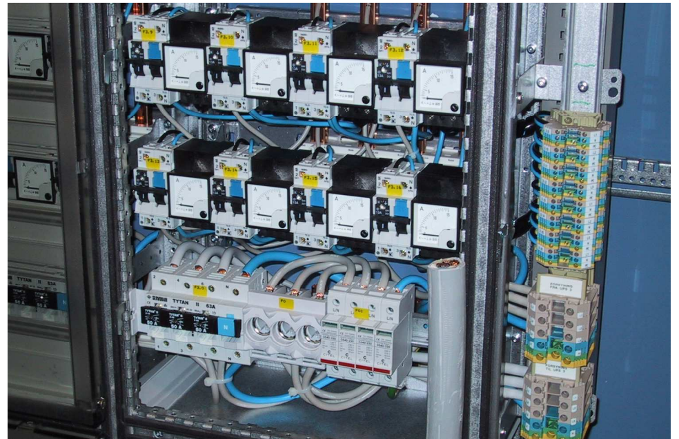
Nov.2001: Installation af nye eltavler
