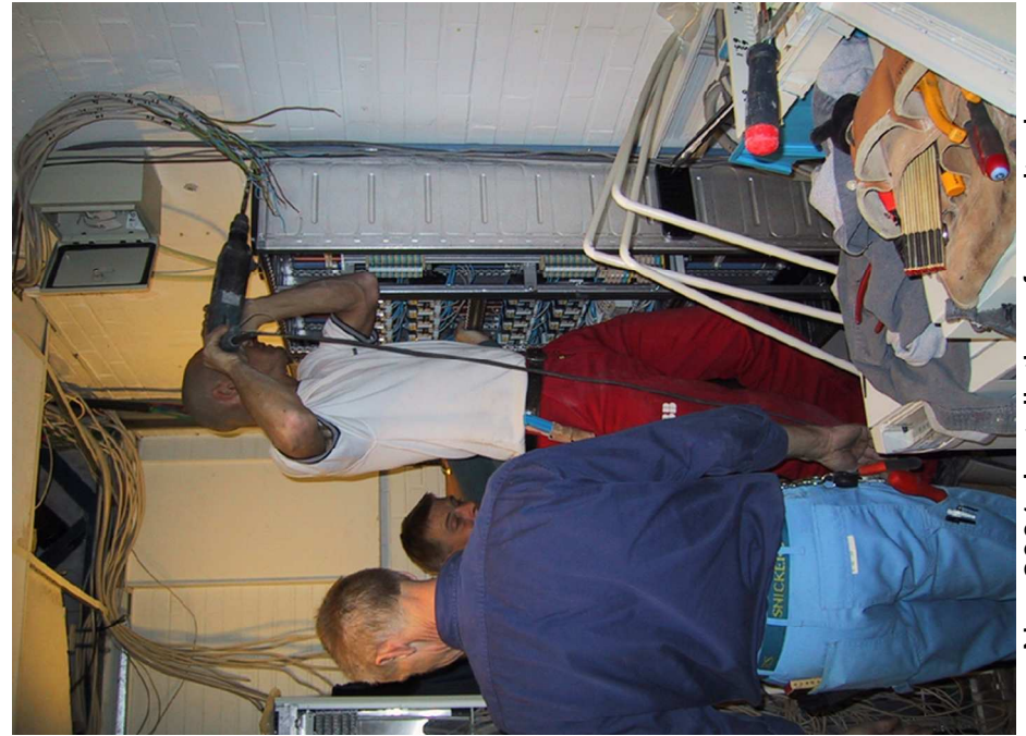
Nov.2001: Installation af nye eltavler
