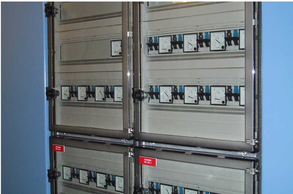
Nov.2001: Installation af nye eltavler
