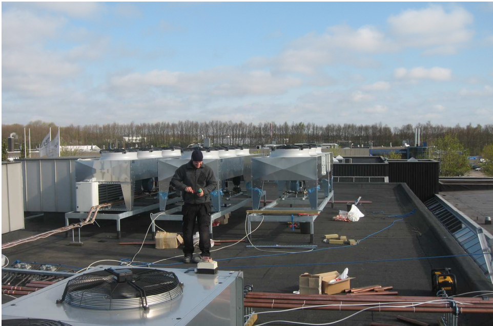
Jan.2009: Der laves ny ventilation
