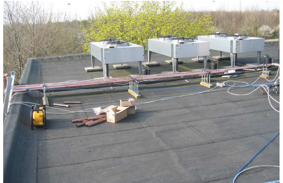
Jan.2009: Der laves ny ventilation
