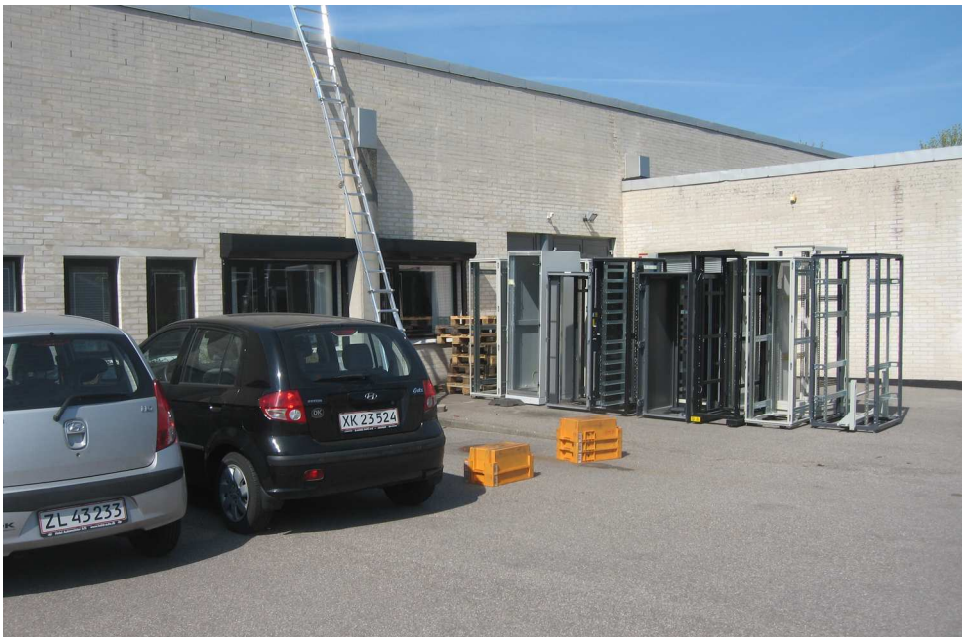
Jan.2009: Der laves ny ventilation
