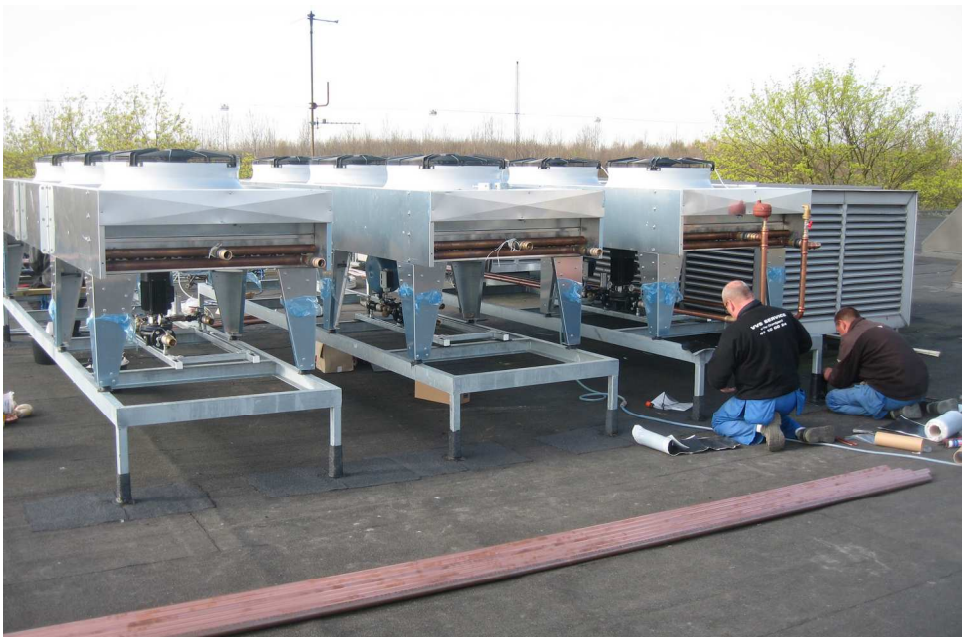
Jan.2009: Der laves ny ventilation
