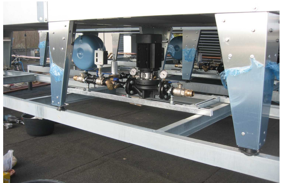
Jan.2009: Der laves ny ventilation
