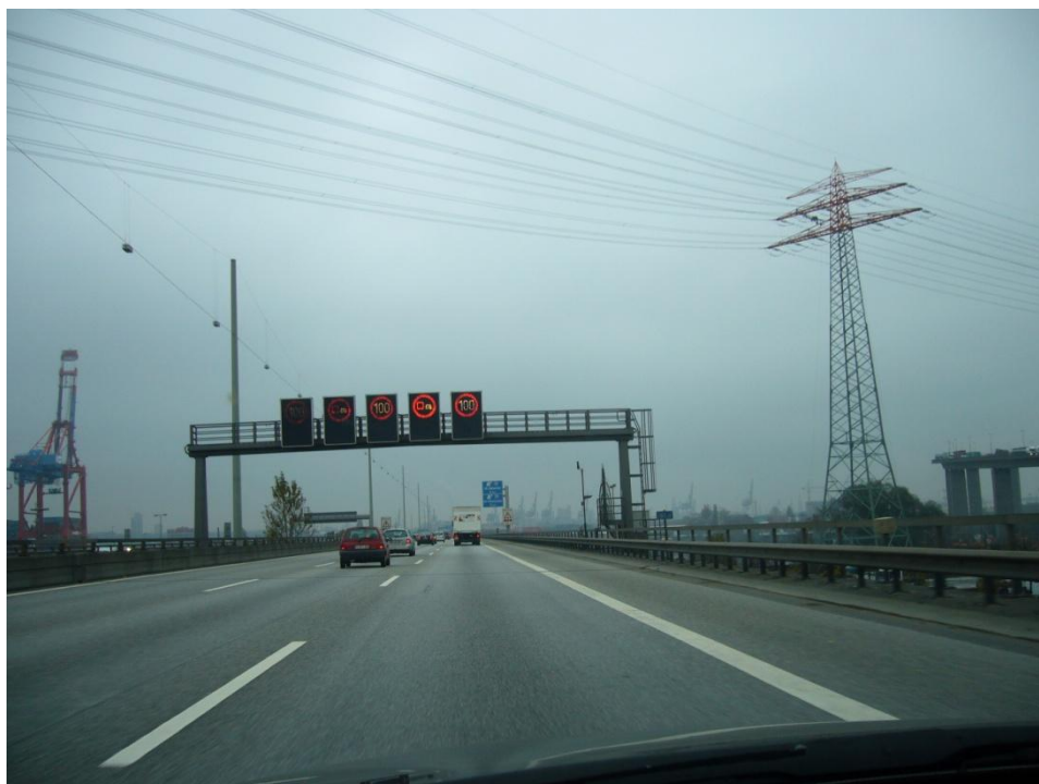
Lige inden nedkørselen til Elb-tunnelen.
