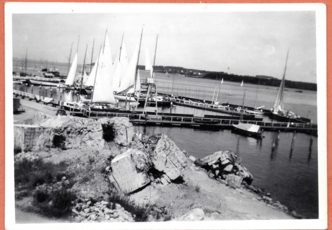
Lystbådshavnen ser ikke ud til at have lidt nogen næneværdig skade.
