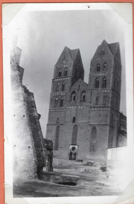
Bomberne er gået gennem jorden, et lag beton og ned i kælderetagen. - Lübeck.
